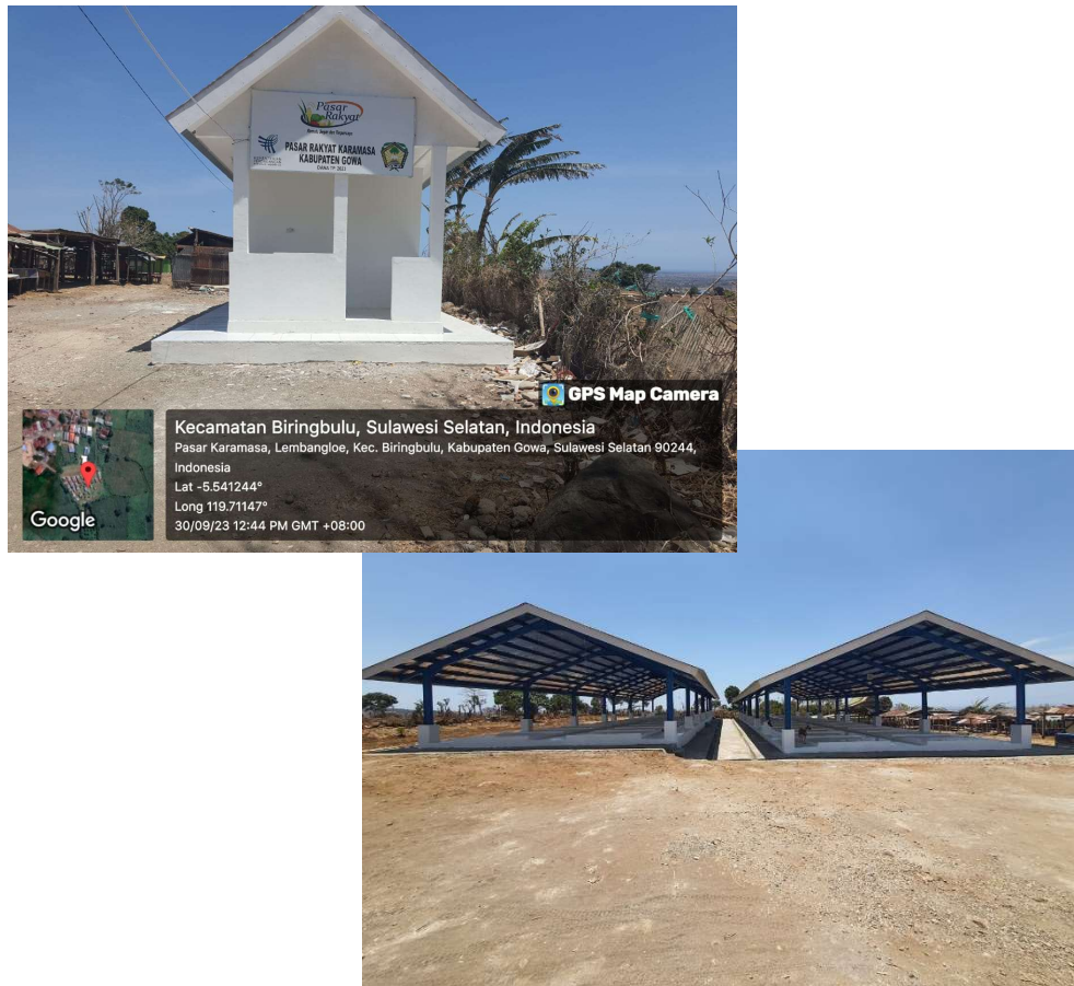
Gambar 3.10 Pembangunan Pasar Karamasa
